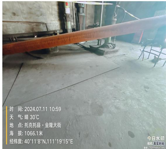
地下原料储存池与原料应急储罐输送管道
