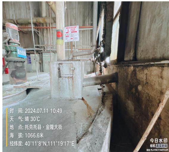
25m<sup>3</sup>的原料储存搅拌池管道连接
