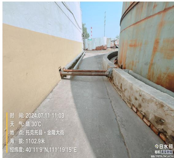
原料应急储罐2座及与车间原料储存搅拌池管道连接
